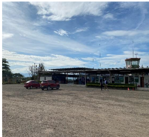
Parqueadero sin señalización
