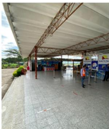
Terminal actual – Zona Circulación
