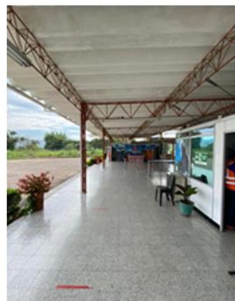
Terminal actual - Zona Circulación
