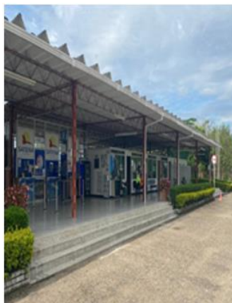
Terminal actual - Zona Circulación
